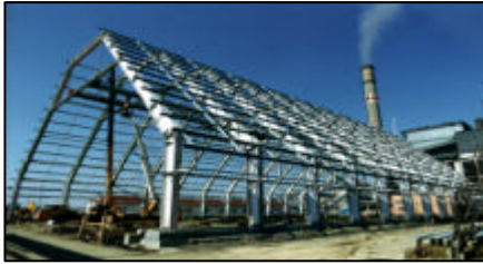
1.b ábra: Mészégető acélváza (Visontai eromu )
